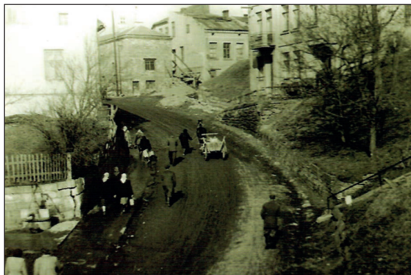
STRZYŻÓW, ul.Sanocka. widok z wiaduktu kolejowego (1956 r.)
